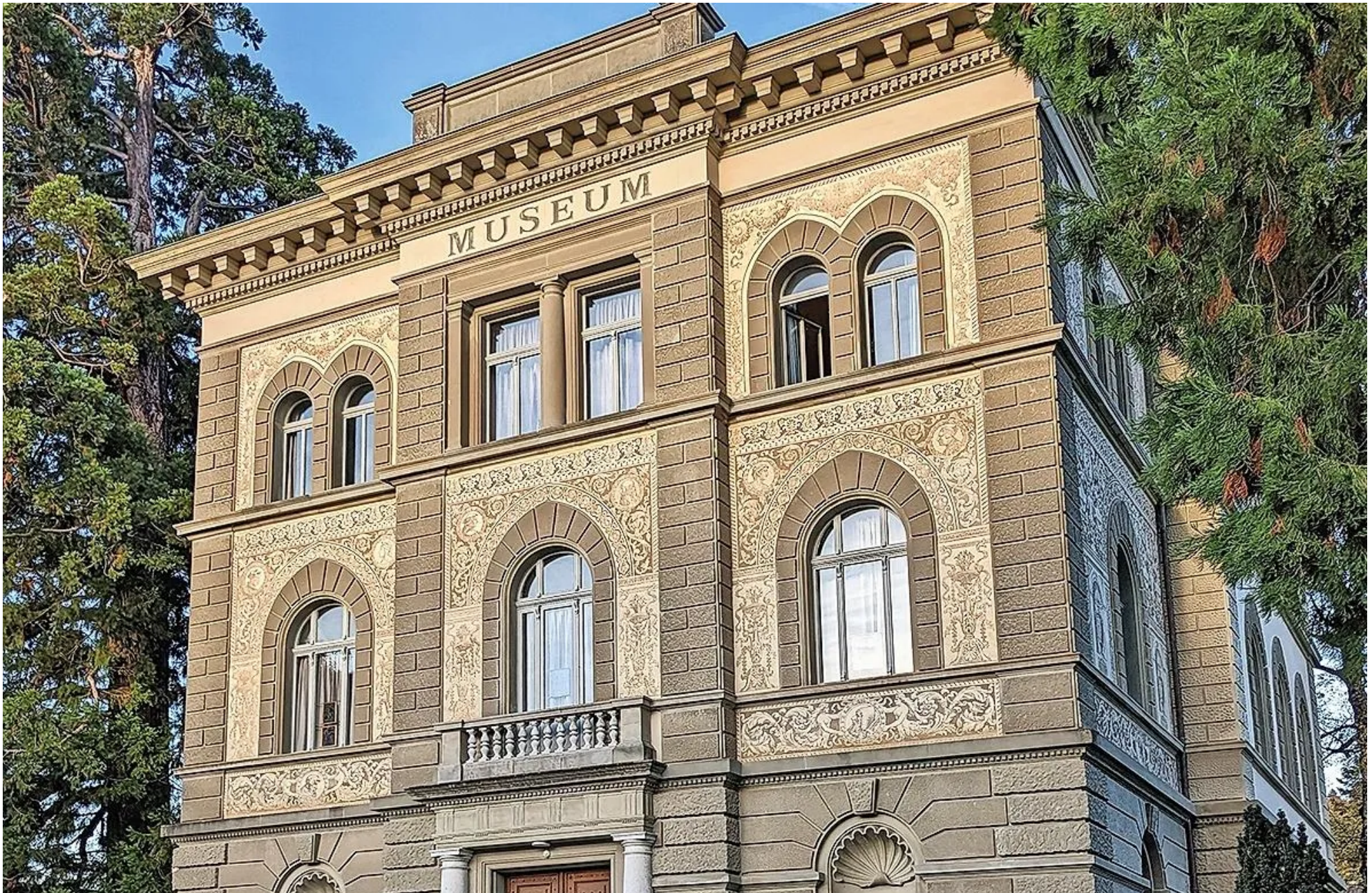
Das Museum Zofingen wurde von 1898 bis 1901 im Stile eines florentinischen Palazzo erbaut. Die Fassaden zieren grossflächige Sgraffiti. Bild: Franziska Schmid-Schärer
