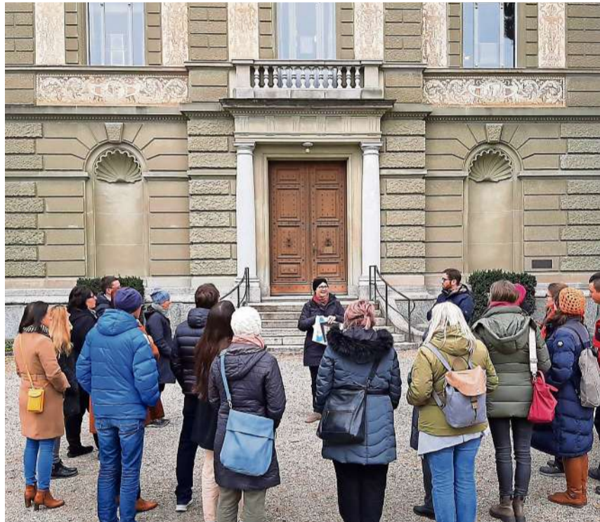
Gespannt hört man Franziska Schmid-Schärer zu, während sie über die Besonderheiten der Fassade erzählt.
